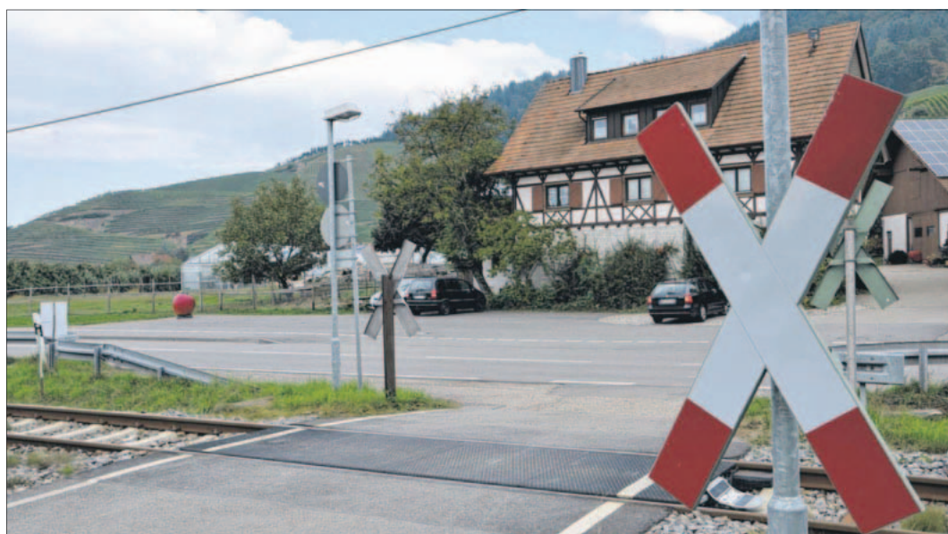
Im Bereich des Bahnübergangs Vorder-Winterbach dürfen Züge maximal 20 km/h fahren. Der Bahn ist die Langsamfahrstelle ein Dorn im Auge, sie will den Übergang nun schließen. Dagegen formiert sich in Lautenbach Protest. Foto: Simon Allgeier
